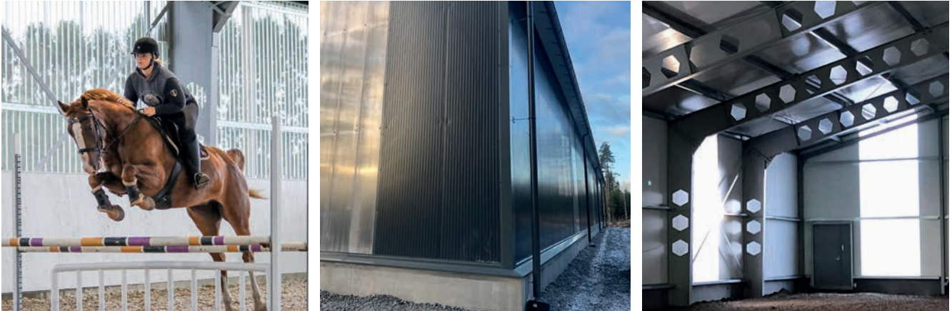
Conexx®-byggnaden har rikligt med utrymme även i höjdlid för byggnaden har inga takstolar.
