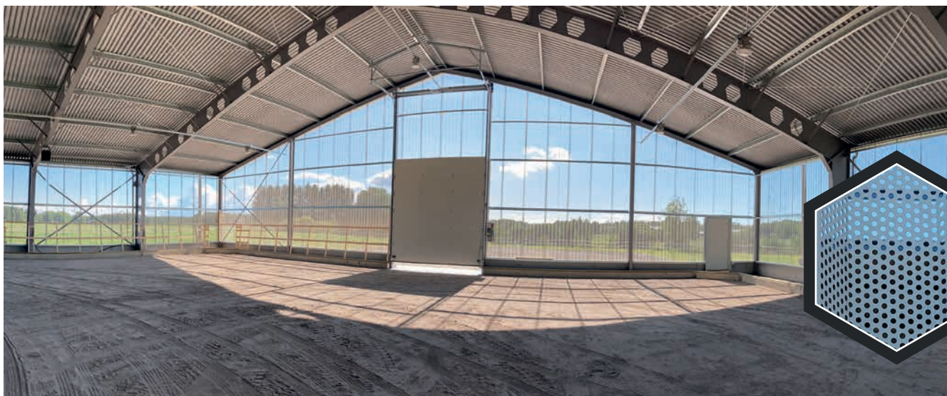
Conexx®-ridhus finns också att få med ljusgenomsläppande perforerad plåt som fasadmaterial. Bild: Losvika Ridhus
