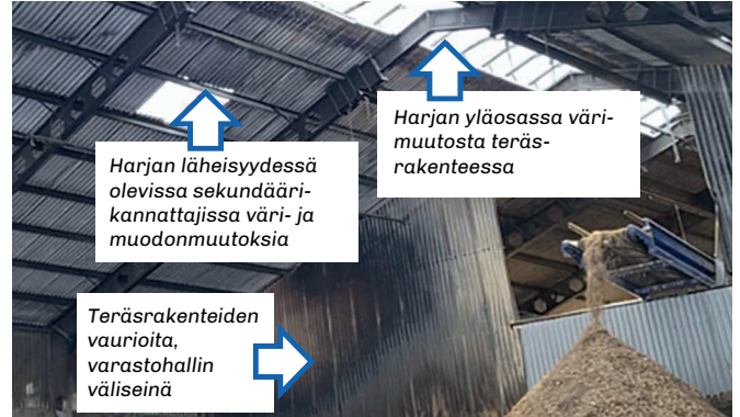
Teräsrakenteiden vaurioita, varastohallin väliseinä.
