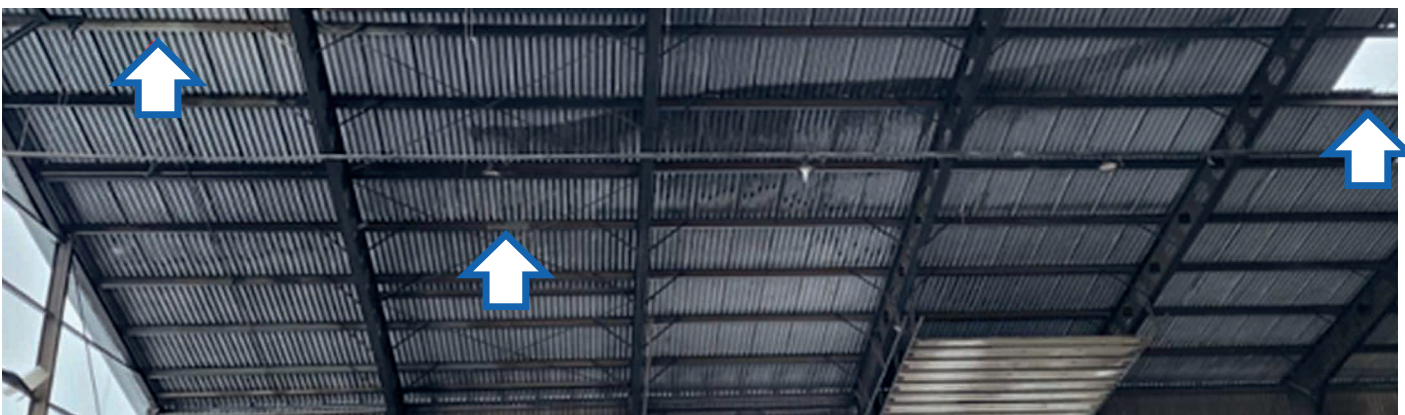
Värimuutoksia teräsrakenteissa.
