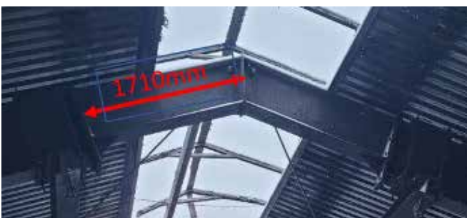
Kattoristikon pintakäsittelyllä tarkoitetaan tätä aluetta harjan kohdalla
