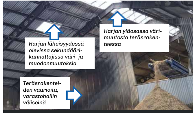
Teräsrakenteiden vaurioita, varastohallin väliseinä
