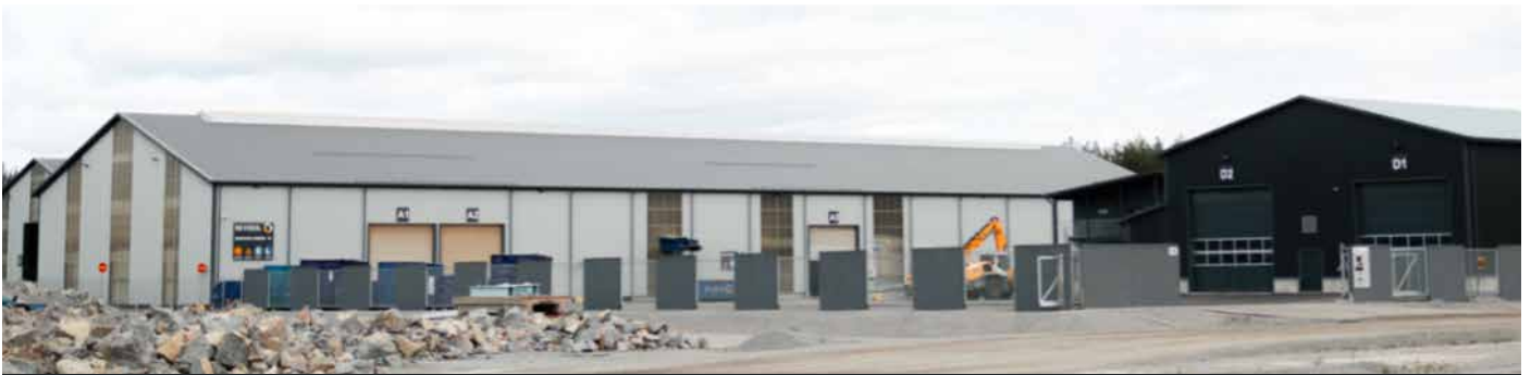
Tulipalo syttyi kuvassa olevassa vaaleanharmaassa rakennuksessa.
