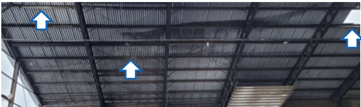
Värimuutoksia teräsrakenteissa
